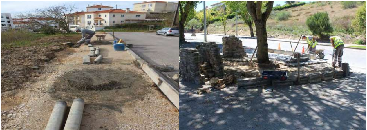
Fotografia 26 e 27: Exemplo de Colocação de Passeios na Vila de Sobral
