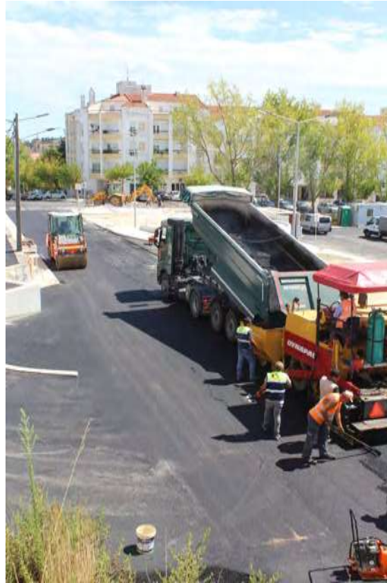
Fotografias 21: Repavimentação Rua Francisco Lázaro e Rua das Poças (Sobral)
