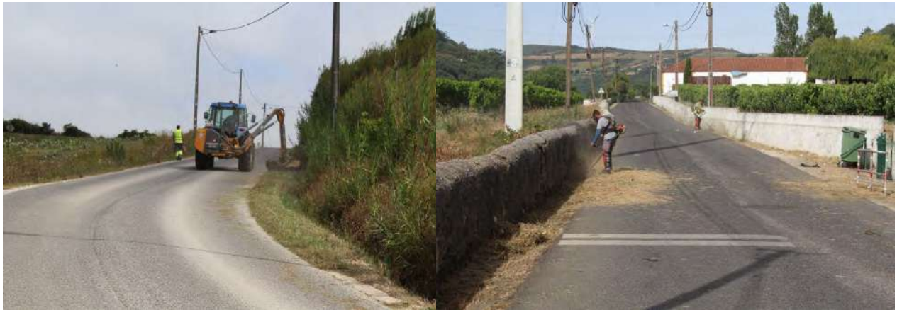
Fotografia 24 e 25: Exemplo de limpeza de bermas no concelho
