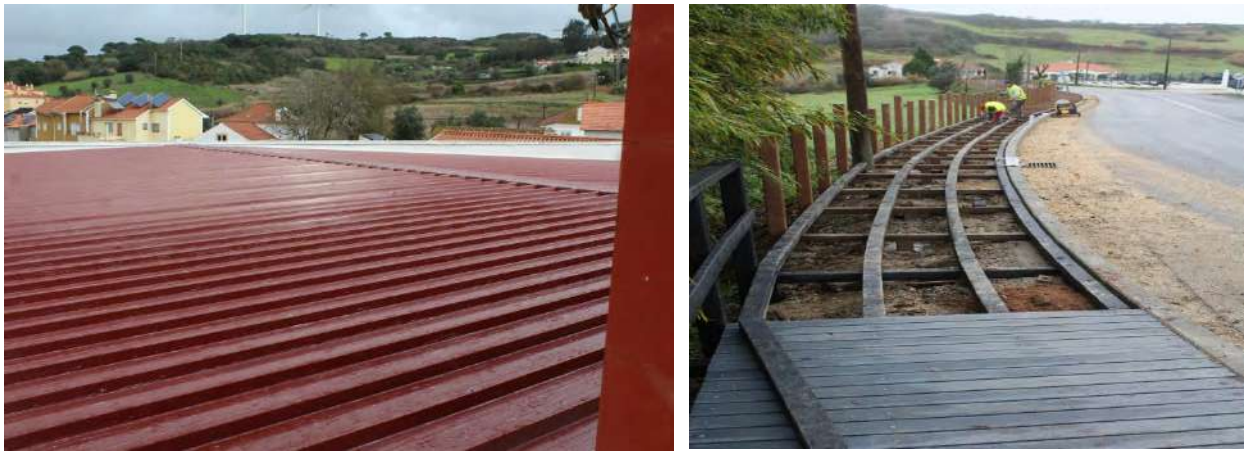
Fotografias 17 e 18: Substituição da Cobertura do Centro Escolar da Sapataria e Via pedonal - Entrada Nascente de Sobral de Monte Agraço
