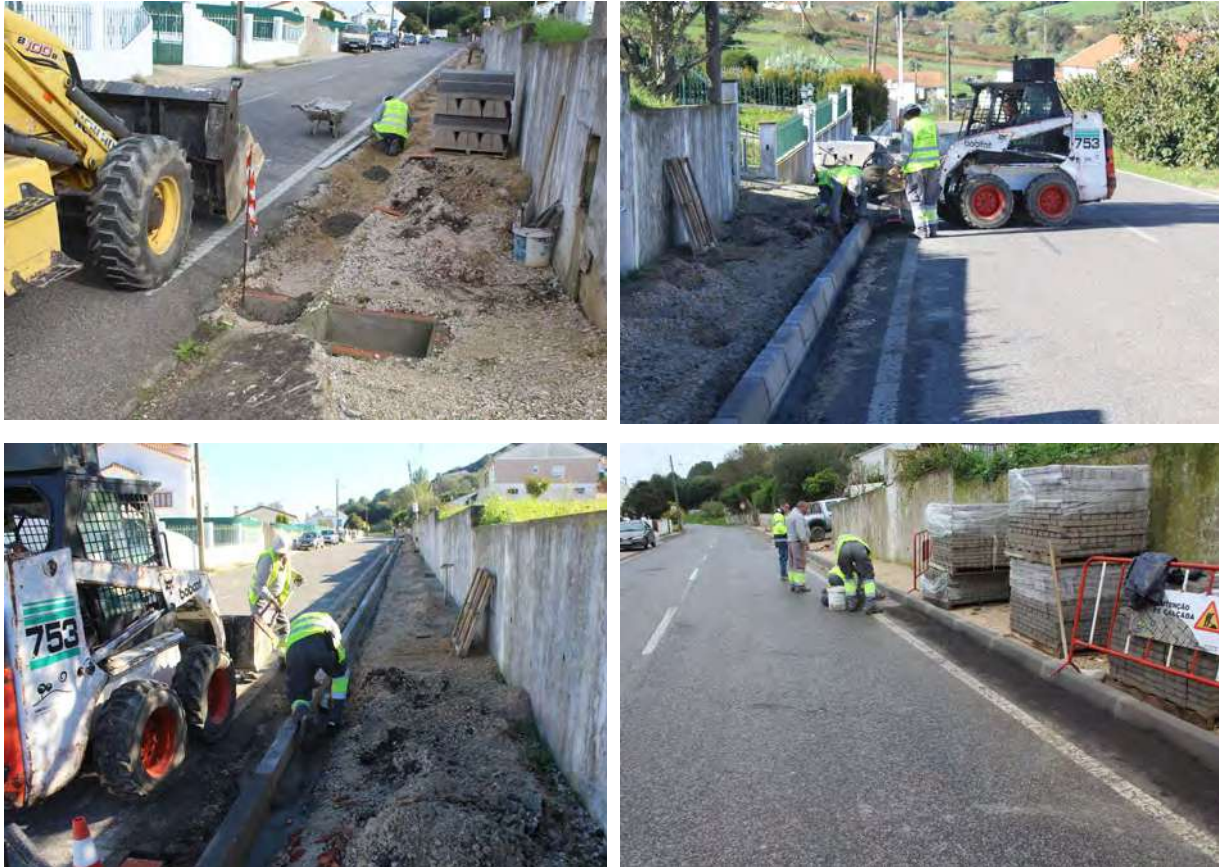
Foto 42, 43, 44 e 45 - Construção de Passeios – Casal da Boiças
