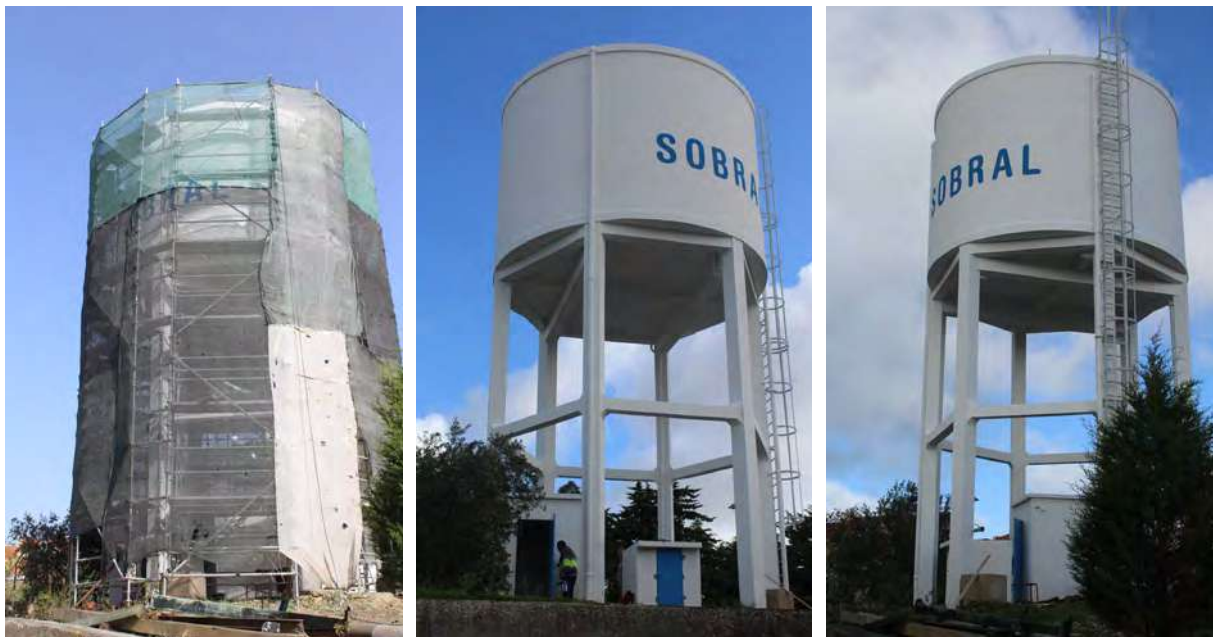
Foto 25, 26 e 27 - Reabilitação e Higieneização do Reservatório Sobral 2
