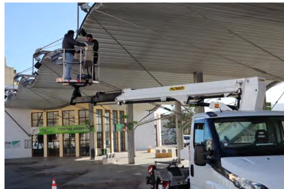
Fornecimento e instalação de luminárias LED para aumento da Eficiência Energética da Iluminação Exterior de Edifícios e Espaço Público
