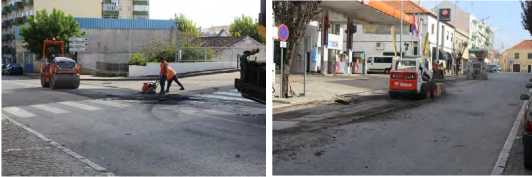
Fotografia 11 e 12: Beneficiação e conservação de vias Municipais – Av. Marquês de Pombal
