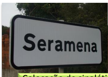
Colocação de sinalética direcional e informativa
