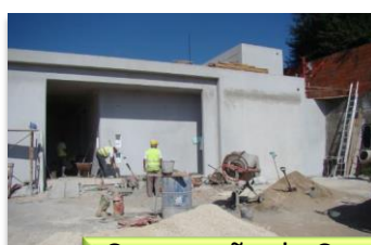
Construção da Casa Mortuária 2 a Fase
