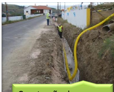
Construção drenos em diversas localidades
