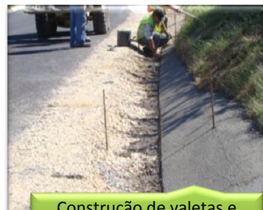
Construção de valetas e nivelamento de tampas de saneamento
