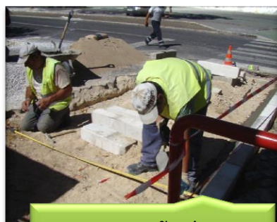
Execução de acessibilidades pedonais
